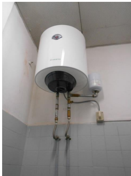
Figura 4.16 – Particolare della caldaia murale per la produzione di acqua calda sanitaria
