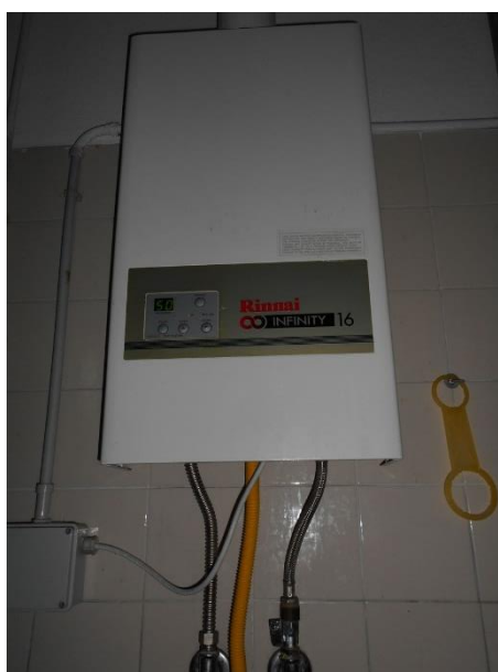
Figura 4.16 – Particolare della caldaia murale per la produzione di acqua calda sanitaria
