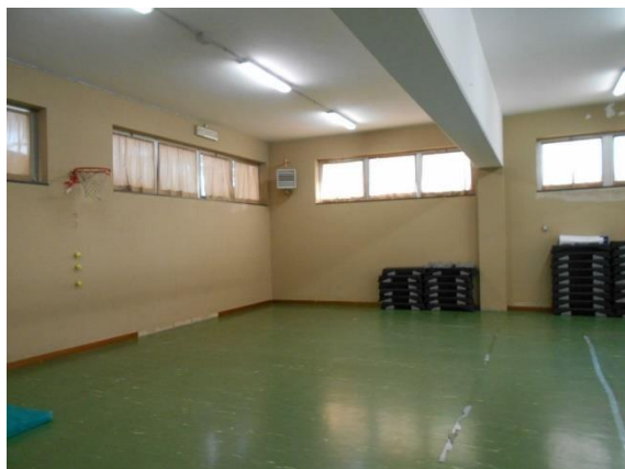
Figura 4.18 - Particolare dei corpi illuminanti ubicati in palestra
