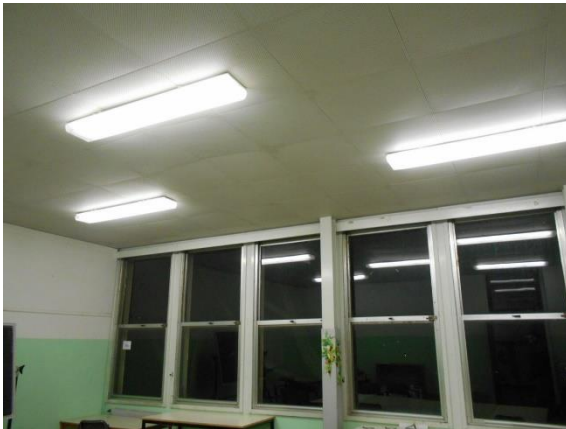
Figura 4.5 - Particolare dei serramenti
