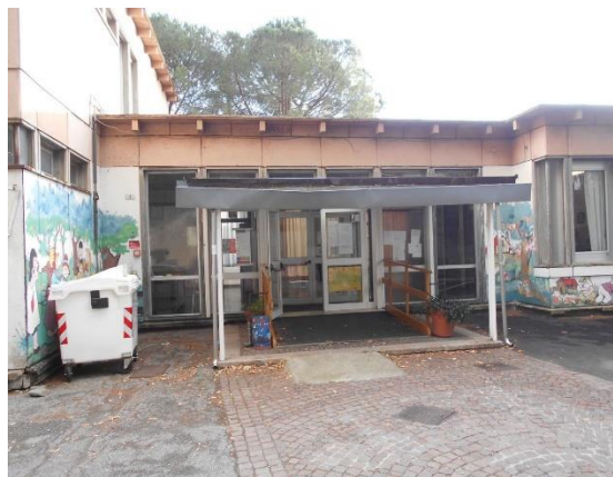
Figura 1.1 - Vista della facciata [esposta a Nord]
