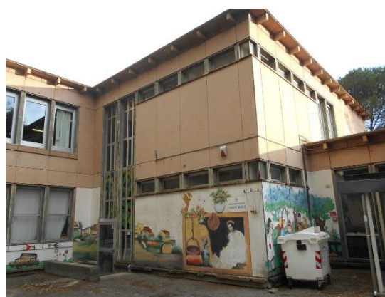
Figura 8.1 - Particolare di una parete esterna
