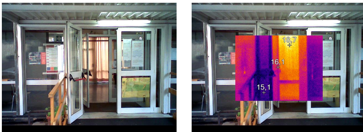
Figura 4.7 – Rilievo termografico dei serramenti
