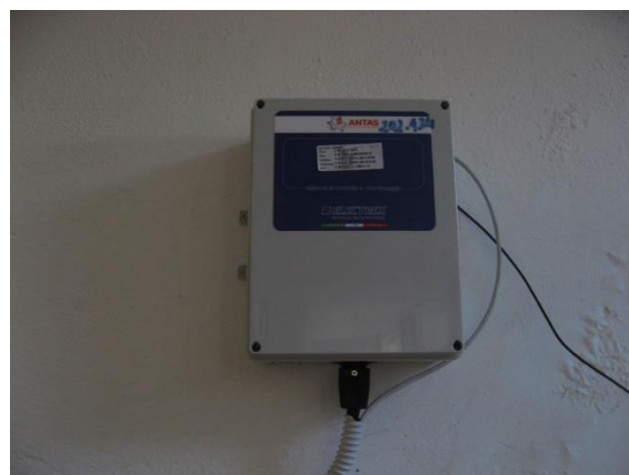
Figura 4.10 - Particolare della centralina di controllo dell'edificio
