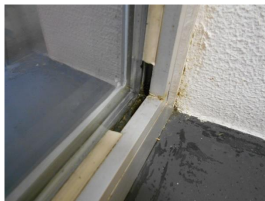
Figura 8.5 - Particolare di un infisso
