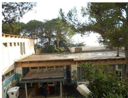
Figura 8.3 - Particolare della copertura
