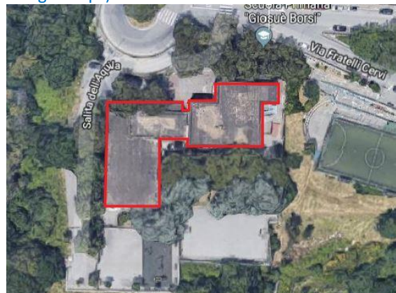
Figura 2.2 - Vista satellitare dell’edificio (Fonte: Google maps)
